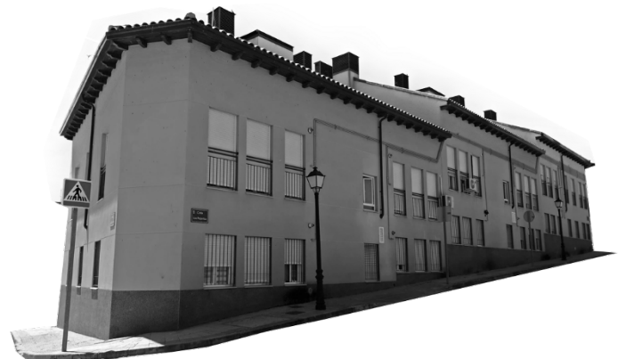
25 viviendas Villarejo de Salvanes
